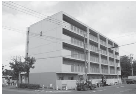
コスト縮減を進めたいずみ団地の建替工事
