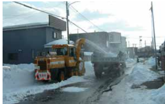
市道の除雪作業
