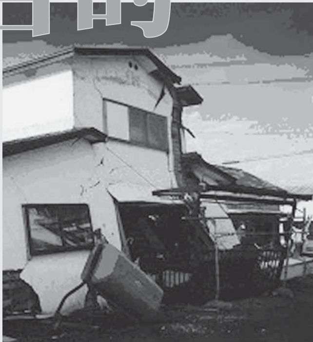
地震の被害は、昭和56年以前に建築された建物に多く発生することが予想されます（写真は平成6年に発生した北海道東方沖地震で倒壊した戸建て住宅）
