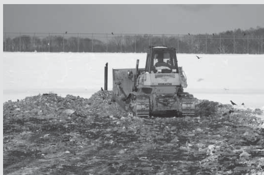
ごみの埋め立てが進む処分場。毎日、たくさんのごみが運び込まれます。
