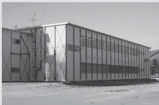
平成19年に増築した富丘中のプレハブ校舎
