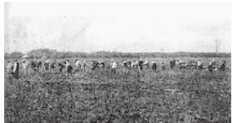
拡張工事の様子
