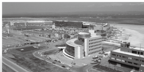
供用開始直前の新千歳空港ターミナルビル
