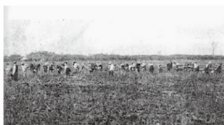
拡張工事の様子
