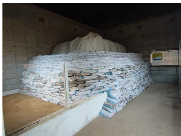
土嚢積み上げ、珪砂充填状況（R5.11下旬）
