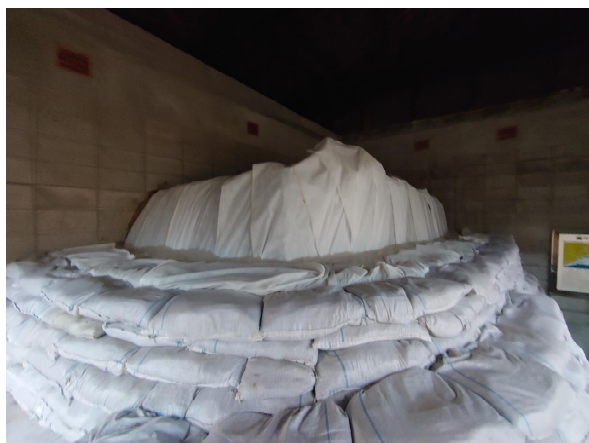
土嚢積み上げ、珪砂充填状況（R5.11下旬）
