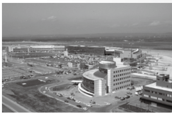
供用開始直前の新ターミナルビル(平成4年5月)
