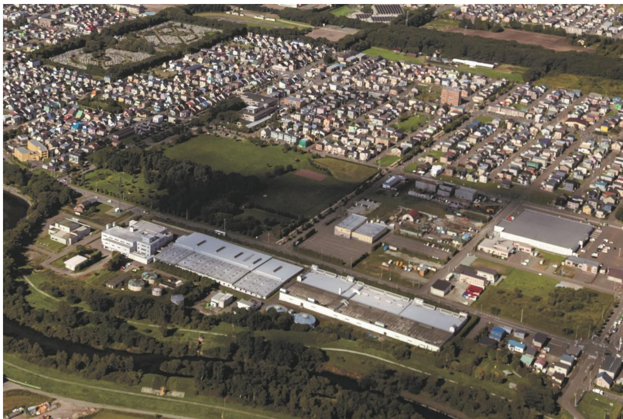
浄化センター
