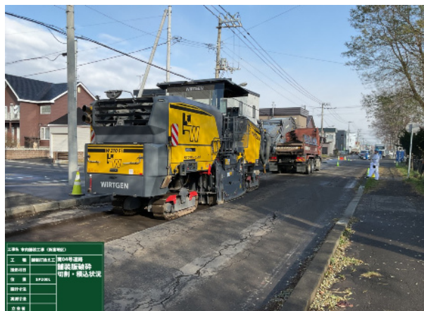
大型切削機による舗装版破碎・積込
