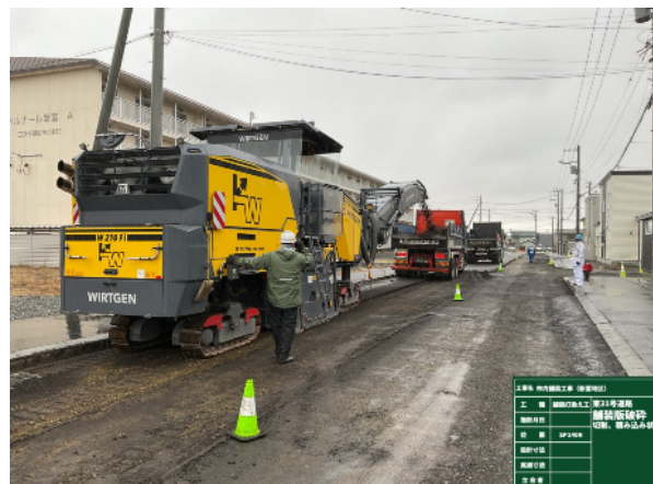
大型切削機による舗装版破碎・積込
