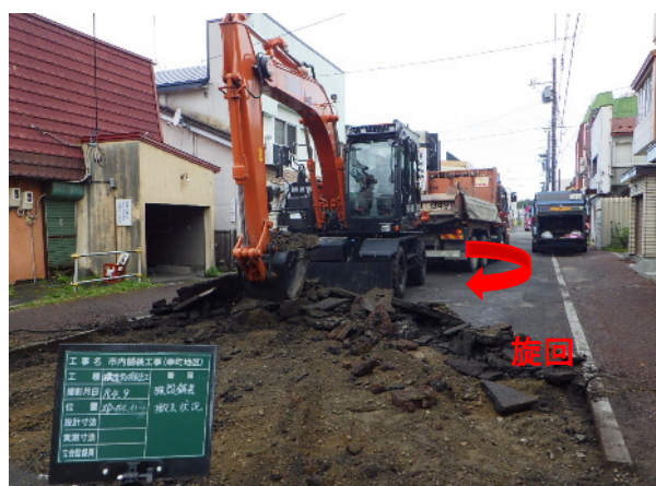
大型切削機による舗装版破碎・積込
