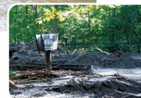
支笏湖地区の被害の様子
