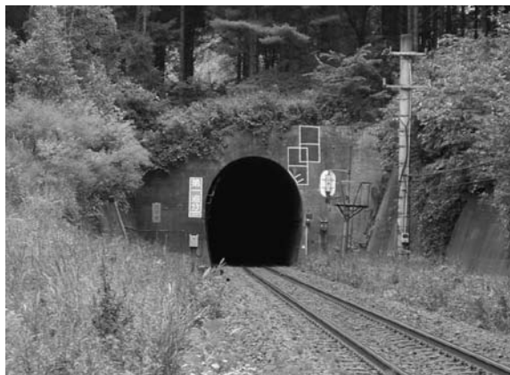
写真4 第一追分トンネル西口（南千歳方） （平成23年10月撮影 Y）
