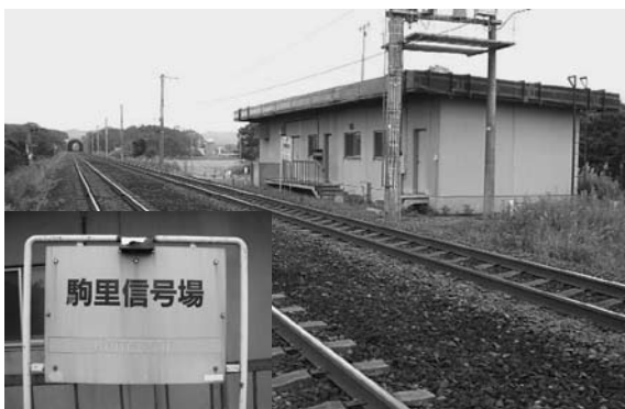
写真5 駒里信号場と分岐部雪おおい(スノーシェルター)分岐は当初Y字だったが平成9年のキハ283系導入時に一線スルー方式としてスピードアップを図った建屋側が上下本線 前方が追分方面(平成23年10月撮影 ㊦)
