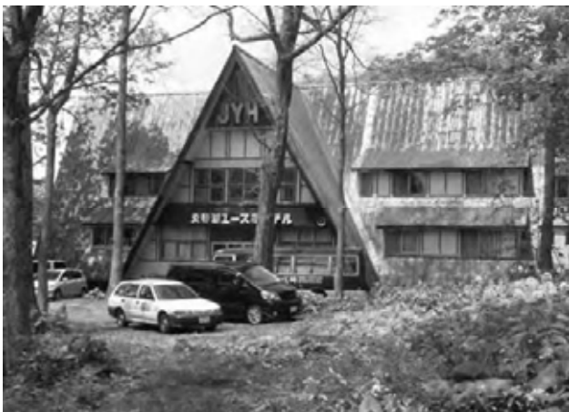
写真-11 改修が必要な支笏湖ユースホステル旧館
