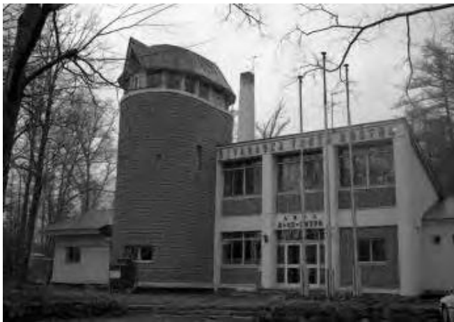
写真-10 札幌宮ヶ丘ユースホステル（平成11年解体・北海道ユースホステル協会提供）
