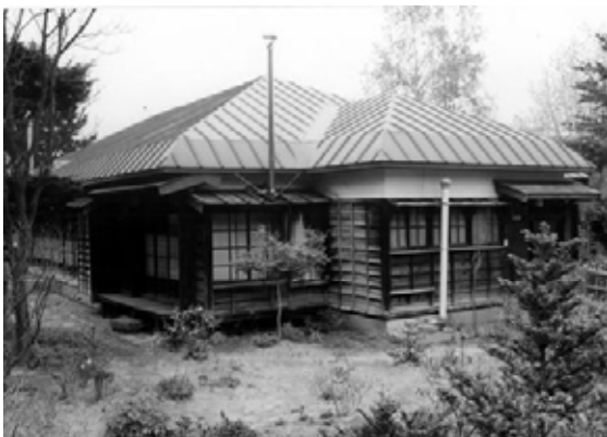
写真一10 旧美幌町長公宅（海軍甲号官舎）
