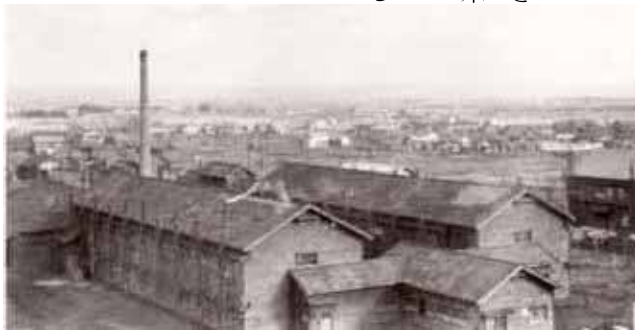
写真一9 第一清和寮（昭和29年）
