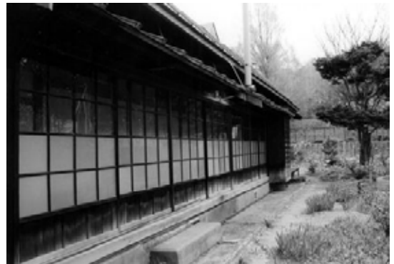
写真一11 旧美幌町長公宅（海軍甲号官舎）
