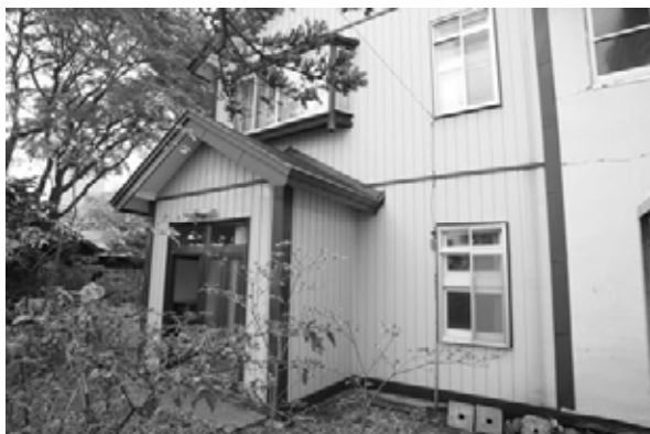
写真-2 現在の渡部家本宅
