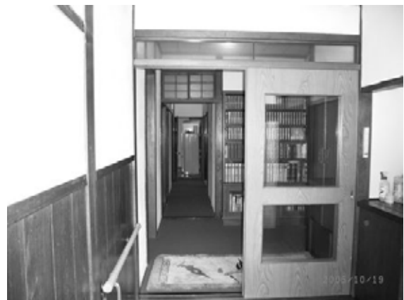
写真-6 乙号官舎内部（玄関から中廊下を見る）
