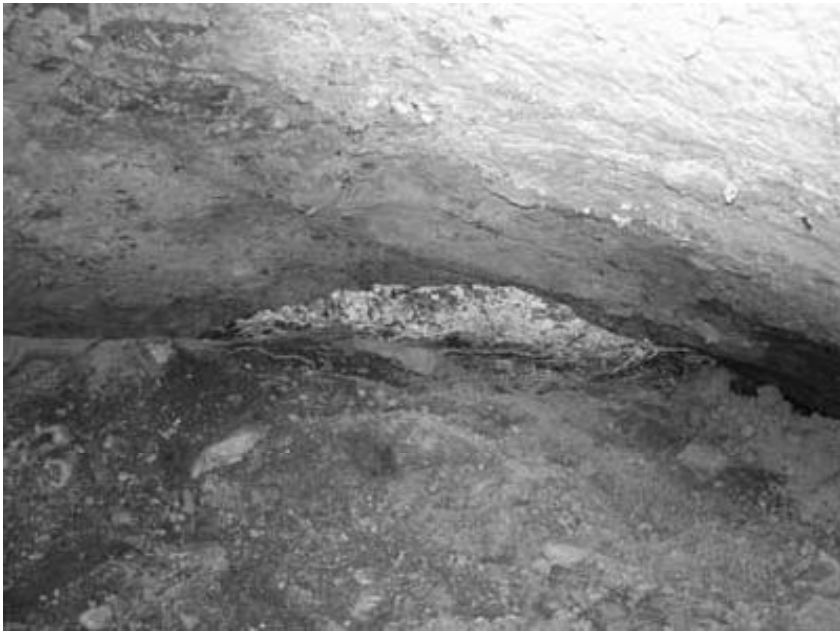
1 壕後部開口部
