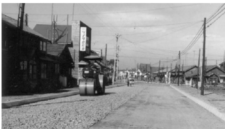
写真-2 中の橋通のトペカ舗装状況
