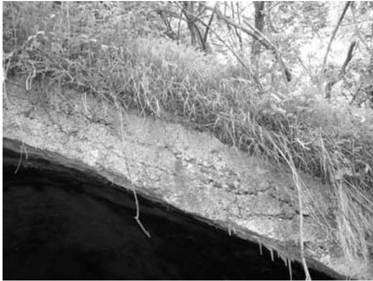
1 有蓋コンクリート（3層になっている）
