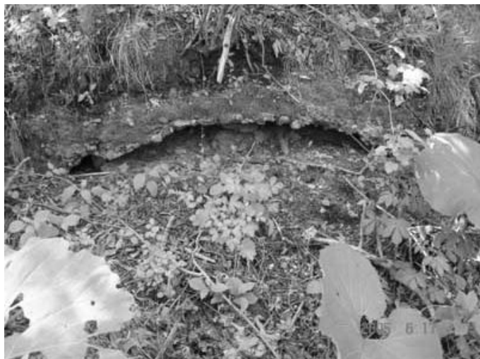
3 壕後部開口部
