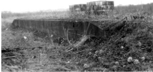
写真一七 第2基地引き込み線 旧POL地区に残るホームとタンク(昭和60年)。
