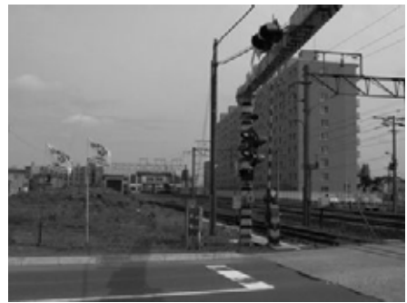
写真-6 長都街道踏切（恵庭市黄金） 線路延長上に橋上の恵庭駅が見える。
