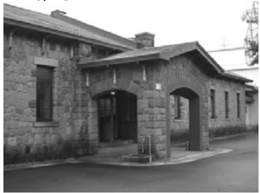
写真-1 北洋館（大正5年建築）：むつ市大湊水交社（海軍士官の社交場）として建てられた。現在は資料館として公開されている。
