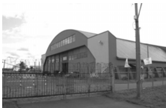
写真-2 現存する旧航空廠施設
