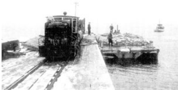
写真-4 支笏湖西岸棧橋とガソリン機関車 白銀丸が艇を曳航し支笏湖東岸に向け出航する。
