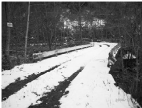
写真-10 廃線跡を歩く（平成18年11月） 上：上流から永代橋を見る－右岸が護岸されている。下：クランク状部分にかかる旧宝来橋－あと700m程で終点本山駅となる。
