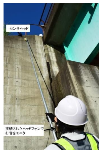
写真10 ポール打音機による 高所点検状況
