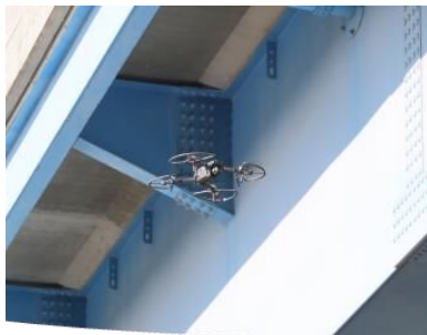
写真7 ドローンによる点検状況
