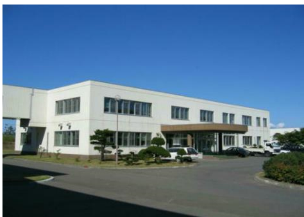
環境センター管理棟
