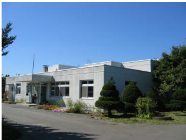
第1排水処理場
