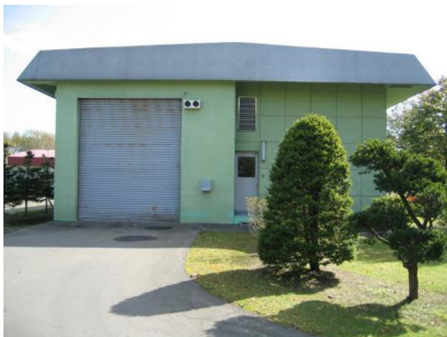
汚水投入施設
