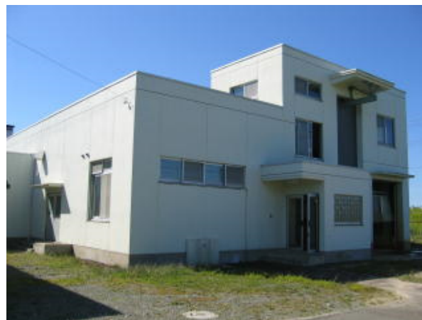
第2排水処理場
