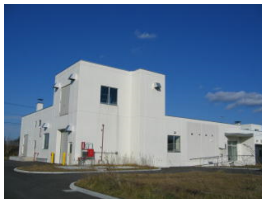
第3排水処理場
