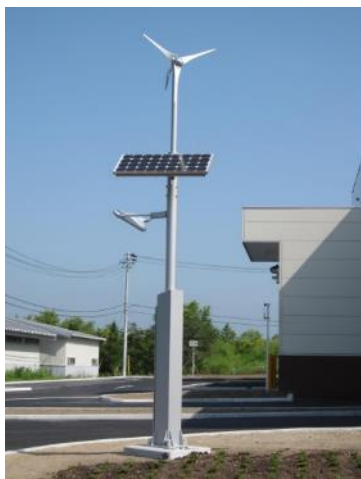
太陽光風力発電 LED 外灯（9W × 2基）
