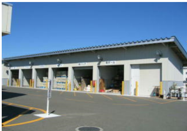
リサイクルセンター（保管庫）
