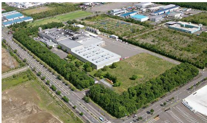
北海道キッコマン樹林地(千歳臨空工業団地内)
