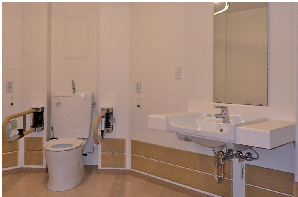
車いす対応住戸のトイレ
