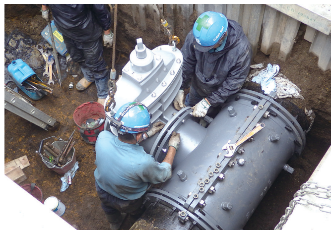
重要給水施設配水管整備工事(配水管路の耐震化を行うための工事)
