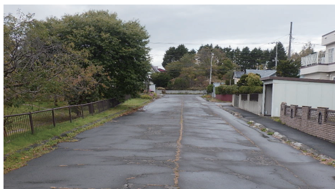
道路の整備前
