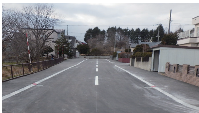
道路の整備後
