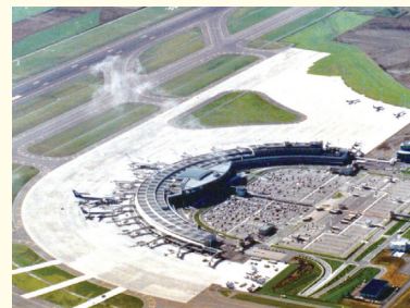
新千歳空港ターミナルビル供用開始
