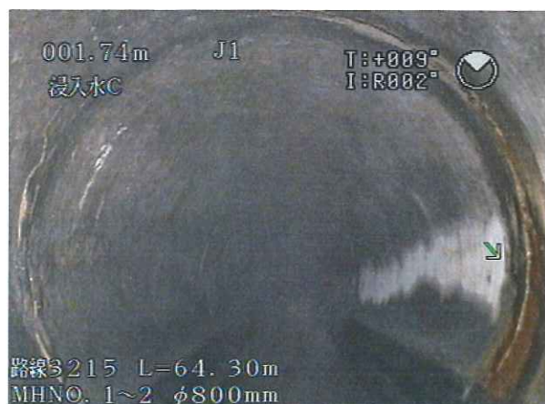
下水道管内カメラ調査
