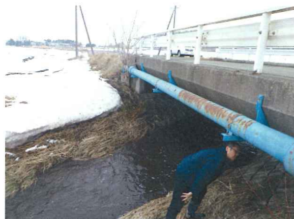
添架管（橋に取りつけた管）点検
