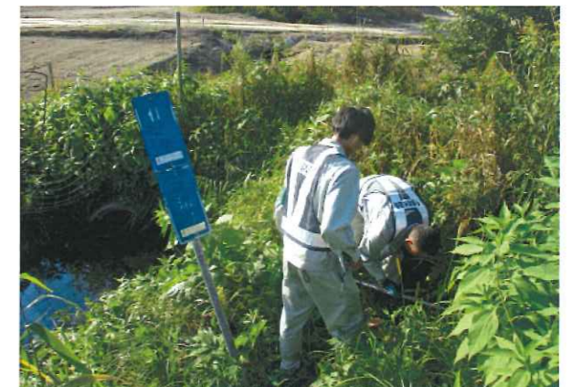
厚真町漏水調査（胆振東部地震時）
