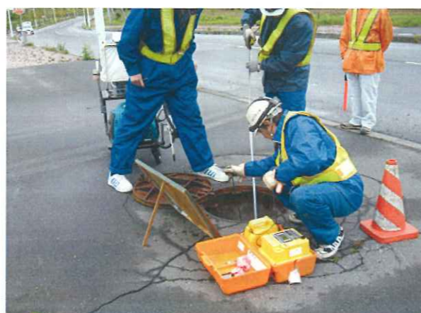
マンホール点検
