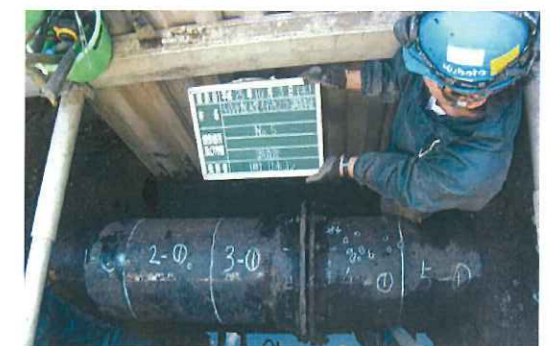
配水管老朽度診断調査
