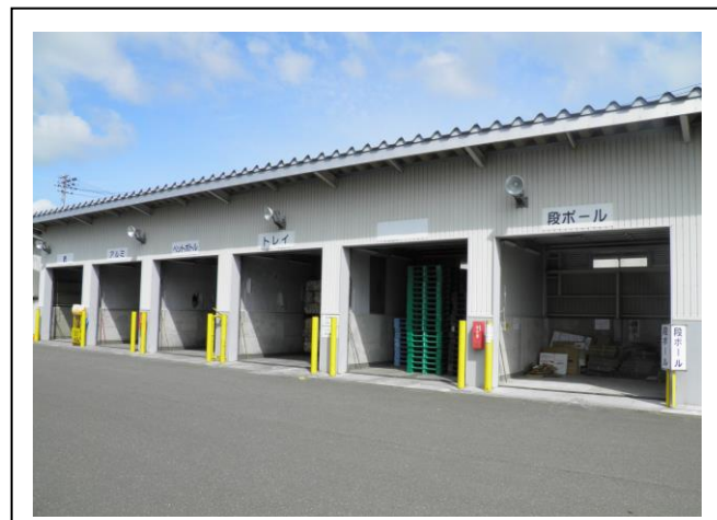
⑫リサイクルセンターの倉庫を見学します。
