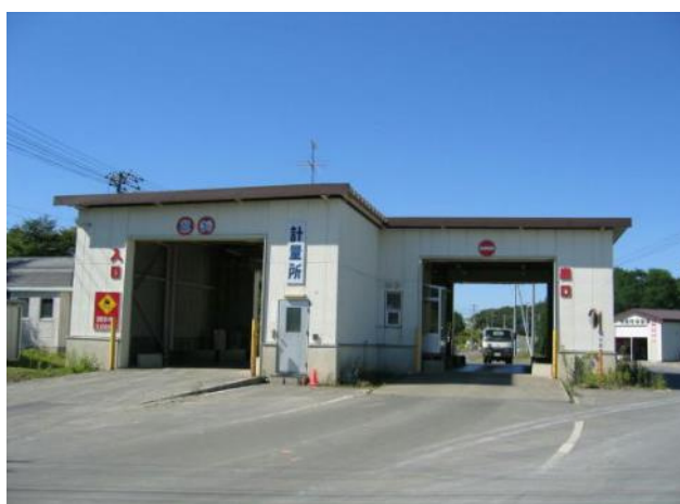
環境センター計量所
