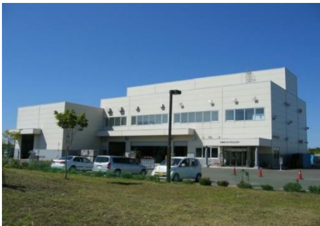
リサイクルセンター（工場棟）
