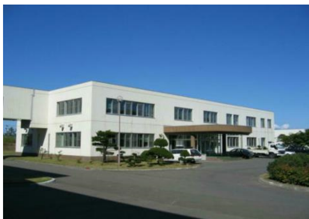
環境センター管理棟
