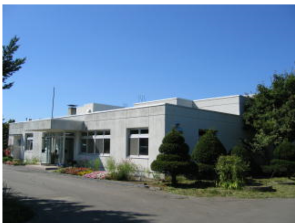
第1排水処理場
