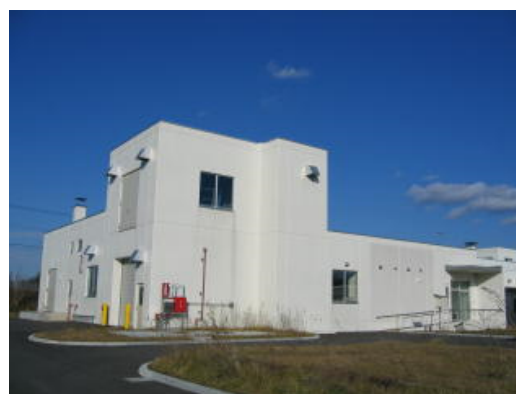
第3排水処理場
