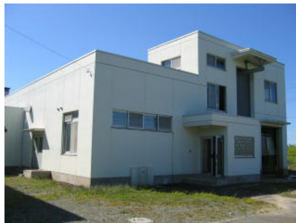
第2排水処理場
