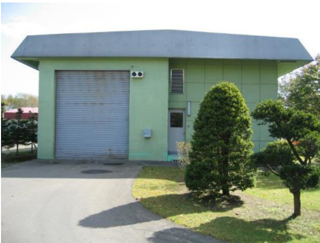
汚水投入施設
