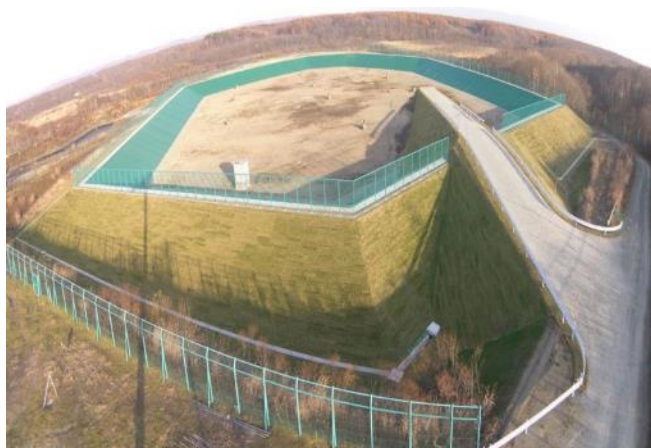
第2埋立処分地（嵩上げ工事後）
