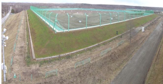
第3埋立処分地（嵩上げ工事後）
