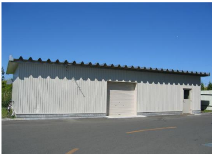
リサイクルセンター 廃家電等保管庫
