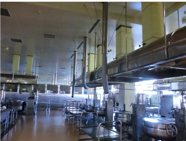
⑬排気フード上部に粉塵が堆積しやすく清掃が困難
