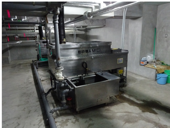
⑮-1 残菜粉碎機をピットに設置
