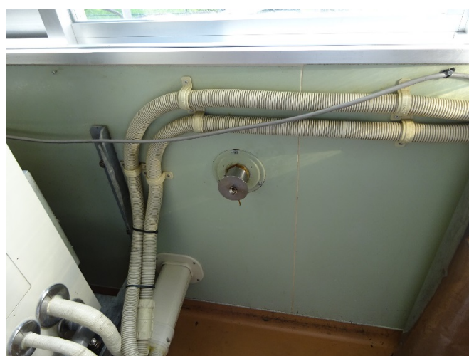
③-2 廃油移送配管を手作業で脱着
