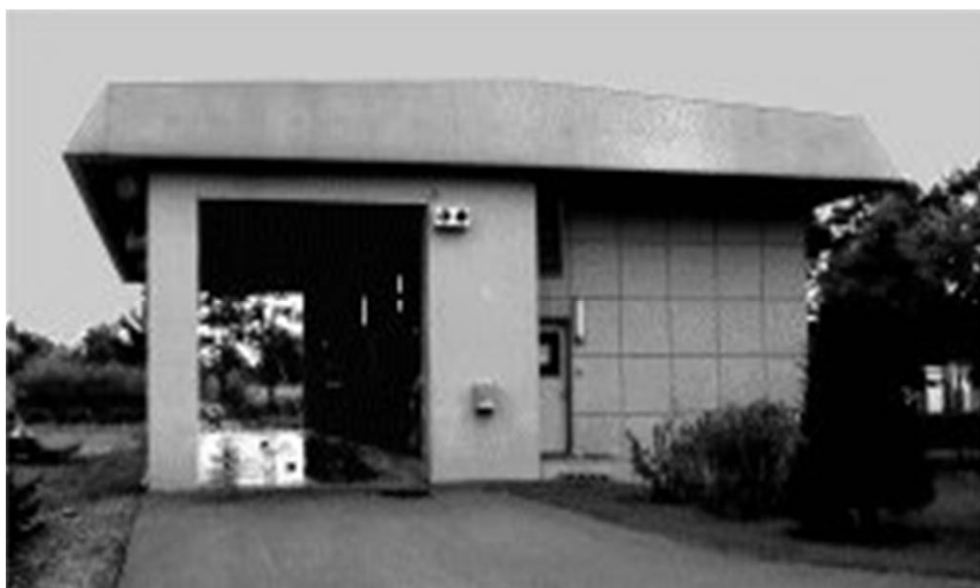
写真 2 - 1 汚水投入施設
