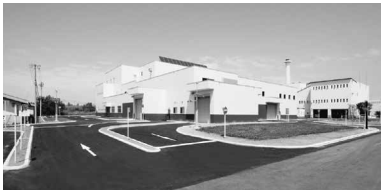
破碎処理場の全景
