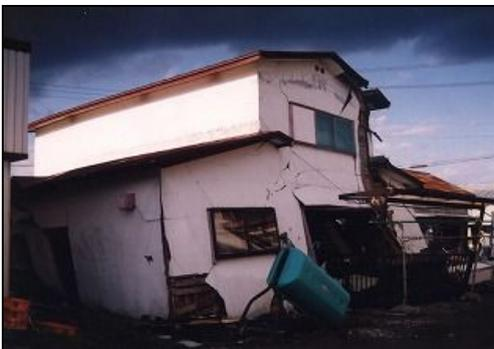
老朽化が進み、耐力壁が不足していることにより、傾いた住宅（北海道東方沖地震）
