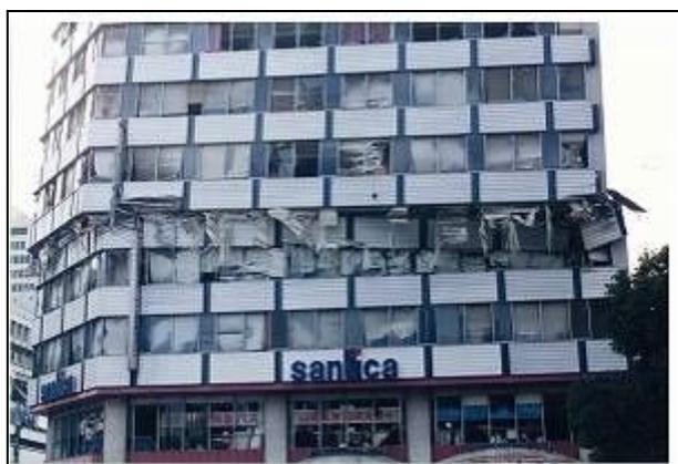
鉄骨鉄筋コンクリート造9階建ての5階部分が完全に層崩壊し、6階以上の階が傾いた商業ビル
