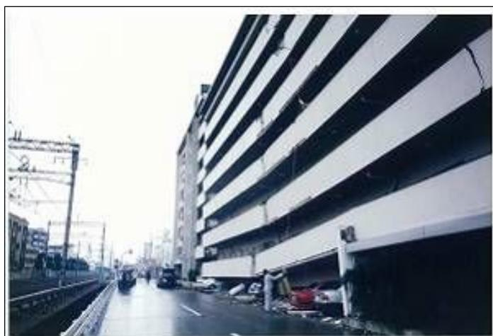
1階を駐車場などで利用するため、ほとんど壁がなく柱だけで支えている「ピロティ形式」と呼ばれる建物の1階部分が崩壊(阪神・淡路大震災) 写真: 日本技術開発(株)提供
