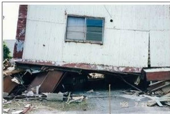
老朽化が進み、耐力壁が不足していることにより、1階部分が倒壊した住宅（北海道南西沖地震）
