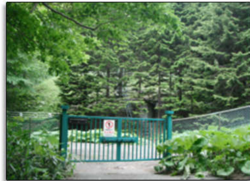
支笏湖配水池
