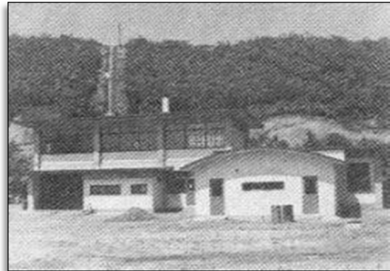
蘭越浄水場管理棟
