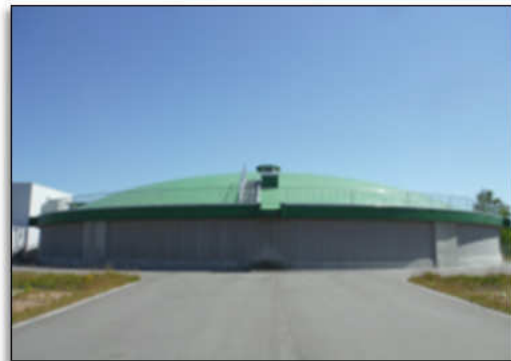
臨空工業団地配水池
