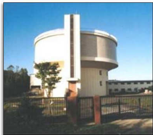
上長都高架配水池
