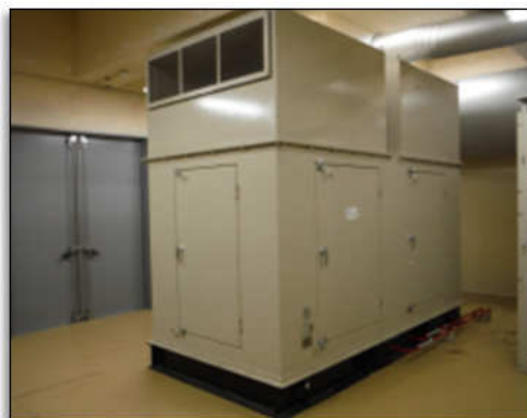
非常用発電機(蘭越浄水場)
