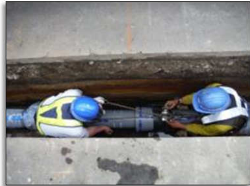
GX 形鑄鉄管※接合状況
