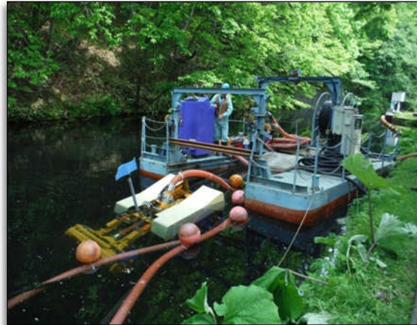
内別川の浚渫 しゅんせつ ※（水中ロボット）
