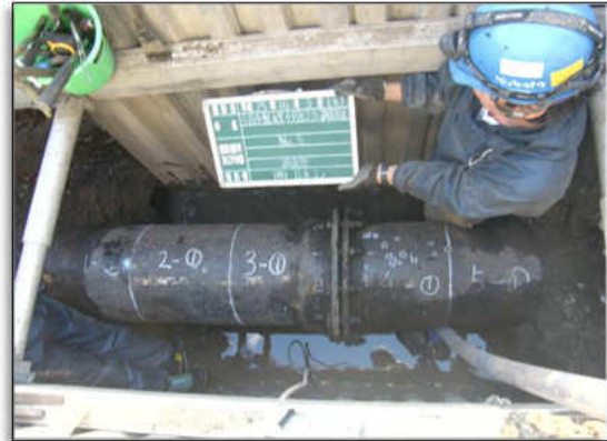
配水管老朽度診断調査
