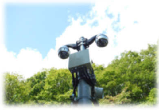
取水口監視カメラ
