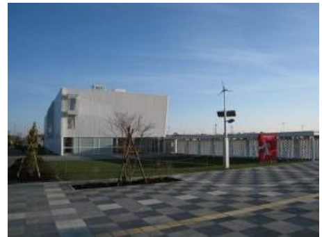
【そなえーる 自然エネルギー導入施設】
