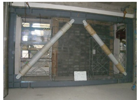
【他市学校の内部鉄骨ブレース】
