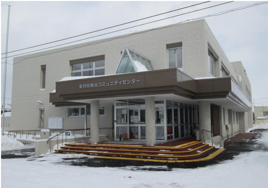
【コミュニティセンター施設整備事業（泉沢向陽台コミセン）】
