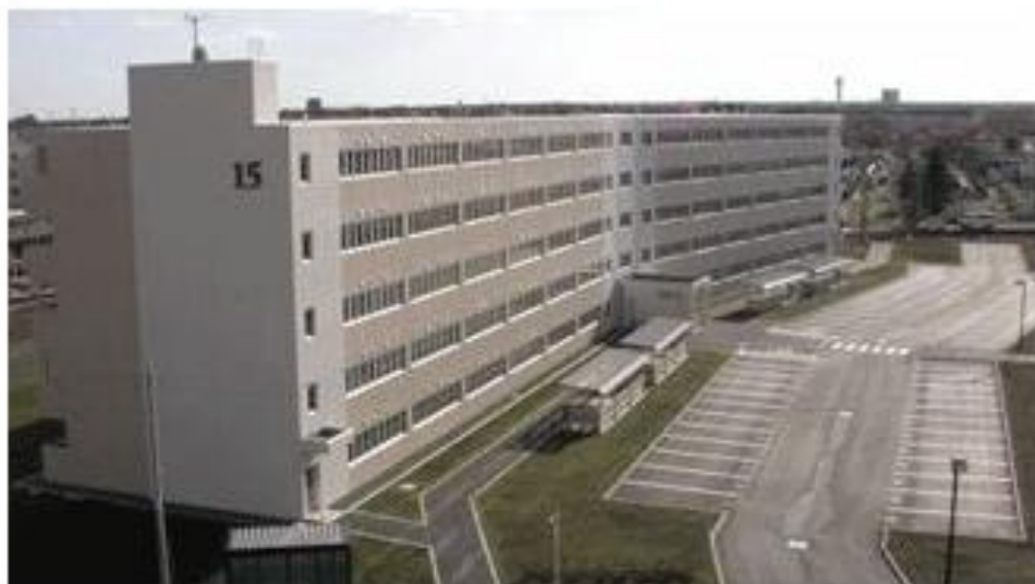
【市営住宅北栄団地（C地区）】 （シルバーハウジング・プロジェクトにより「福祉 拠点型公営住宅団地」として整備されています。）
