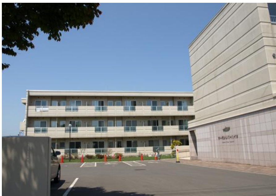
【サーモンリバーハイツ】 （「高齢者向け優良賃貸住宅」の認定を受けた民間の供給している高齢者向けの賃貸住宅です。）
