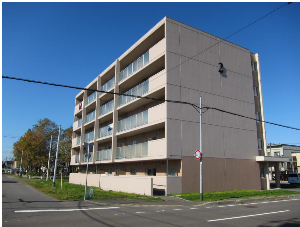
【老朽化が進んだ市営住宅の建替え事例（いずみ団地）】
