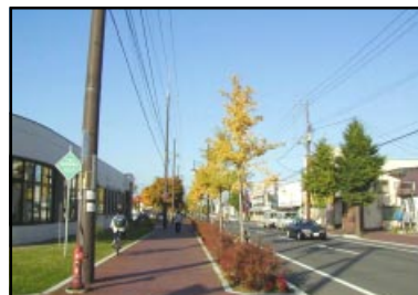
電柱の後退により電線と高木の接触の回避
