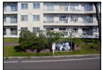
緑化により修景されたゴミステーション
