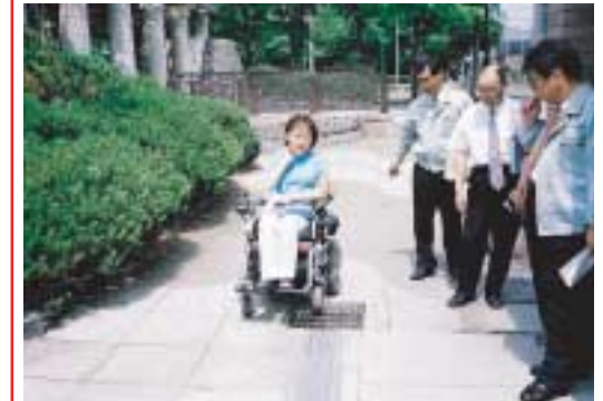
雨水柵の蓋の格子間隔が広いと車をはまる。マンホールの凹凸も走行に支障をきたす。
