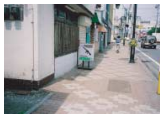
電柱等で一部、歩道が狭くなっている。
