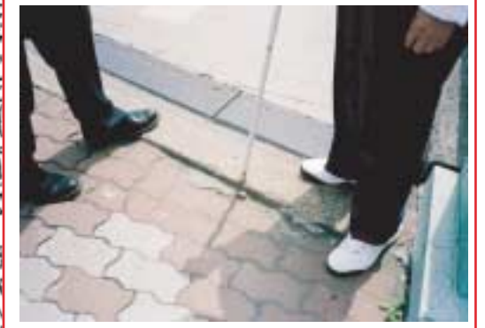
歩道にくぼみがあり危険。
