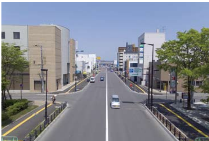
電線類地中化整備が行われた駅大通(国道337号)
