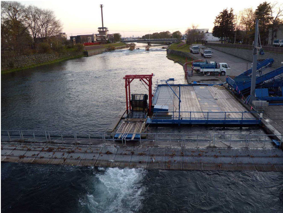
千歳川を遡上する親サケを捕獲する捕魚車（インディアン水車）
