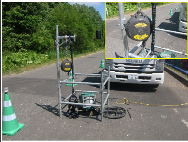
資料写真3 「安全仮設備等の工夫」
