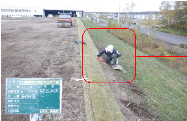
法面用足場の使用
