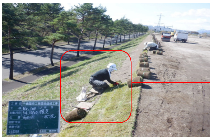
法面用足場の使用
