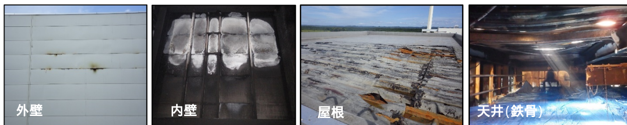
写真3．建築設備の被害状況
